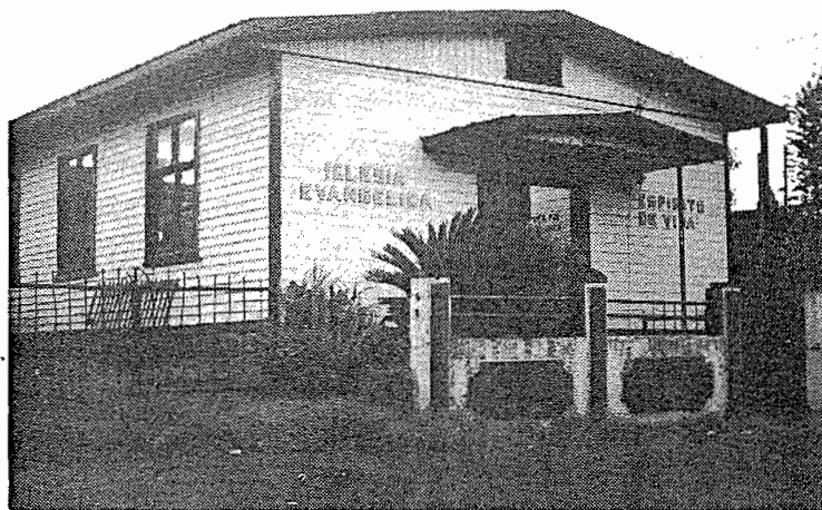
Templo de la Iglesia de Cachí, Cartago. Actualmente está en construcción uno nuevo, el cual próximamente se inaugurará.
